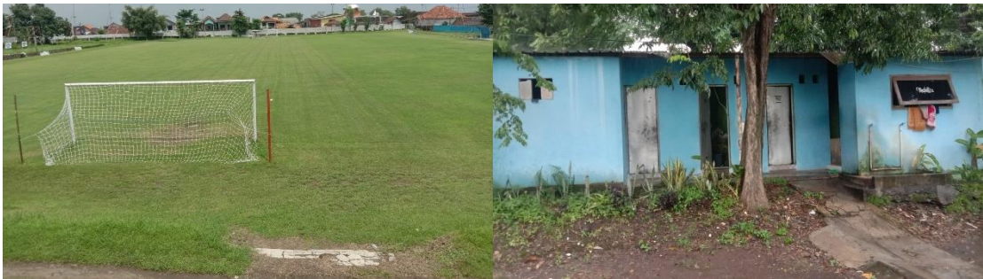
Gambar 3 Dokumentasi Kondisi Eksisting Lapangan Plumbon
