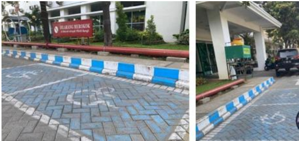
Gambar 4.11 Dropzone Disabilitas Rawat Jalan
