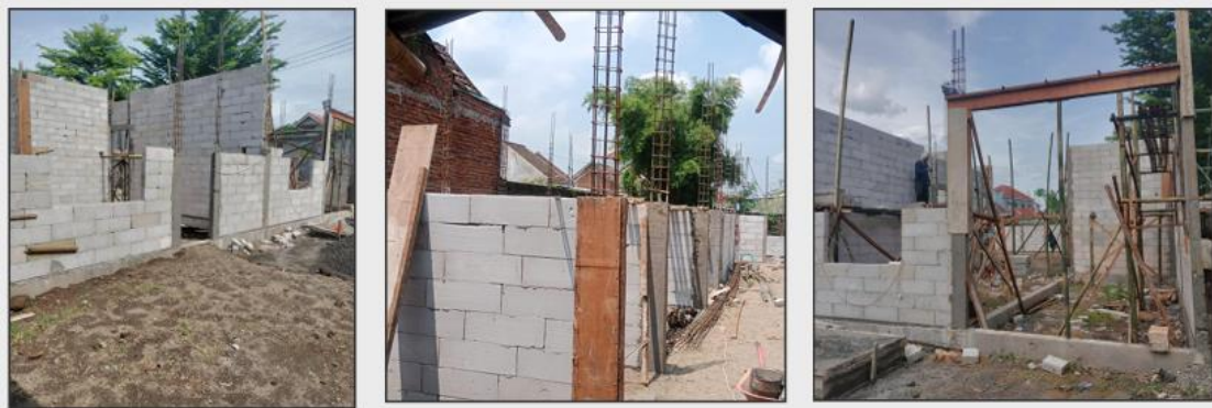
Gambar 3.2 Progres Konstruksi Struktur SPPG Kraton
